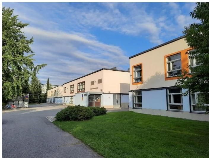
Kuva 3: Valokuva Opiskelijankadun puolelta vuoden 2009 muutosten jälkeen.
